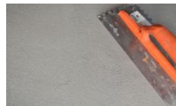
Verser l'application manuelle : utilisez une spatule lisse.
