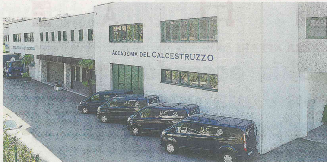
La sede dell'Accademia del calcestruzzo a Renate
