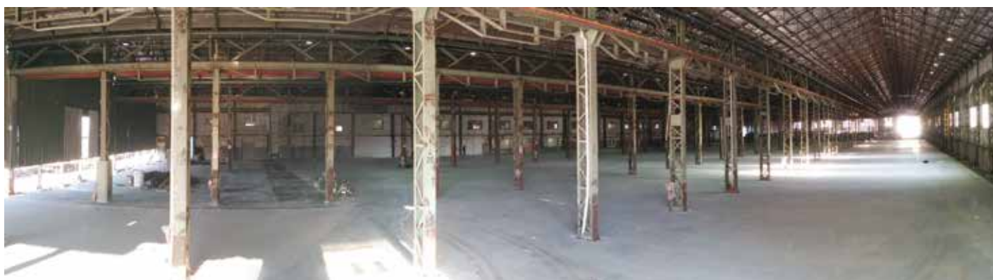
1. Vista panoramica della pavimentazione post-tesa nel Magazzino 7 "Multiservice" a Marghera (VE)
