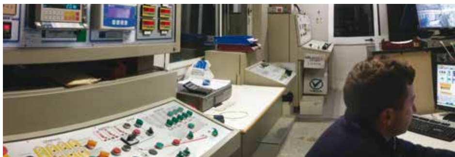
12. La cabina di carico della centrale di betonaggio
