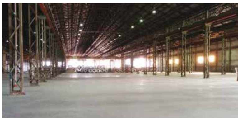
17. La realizzazione della pavimentazione post-tesa della fase 1 completata
