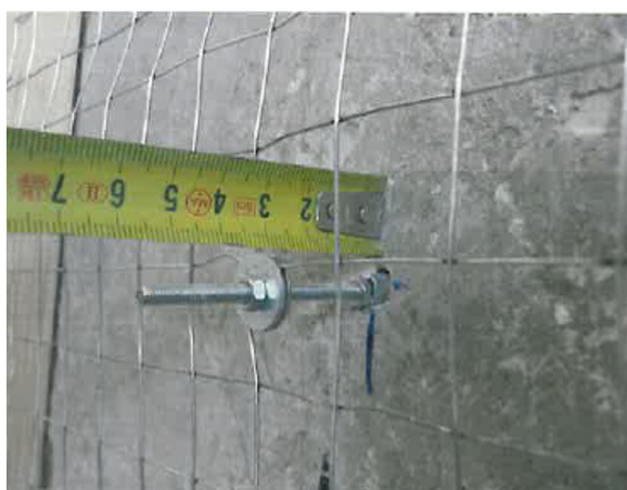
Particolare fissaggio rete elettrosaldata.
