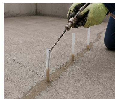
Ripristino di struttura orizzontale
