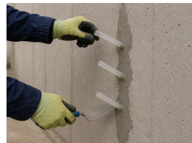
Fissaggio degli iniettori con EPOTEK FIX
